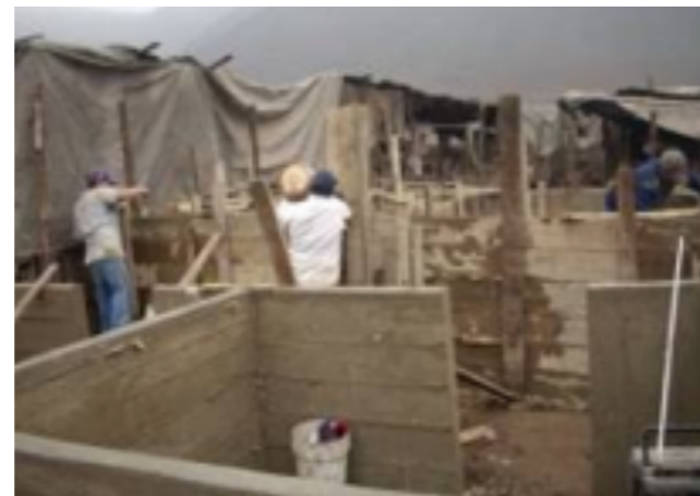
Construcción de corrales
